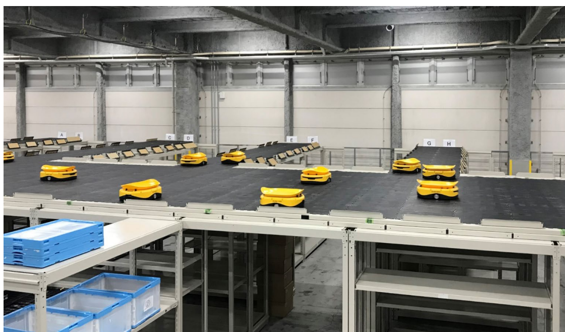
空間を有効活用した富士ロジテック・ネクスト現場
